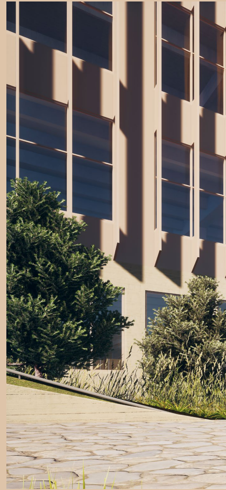
Das Lagergebäude ist unter anderem durch eine Brücke mit dem Funktionsgebäude verbunden.
