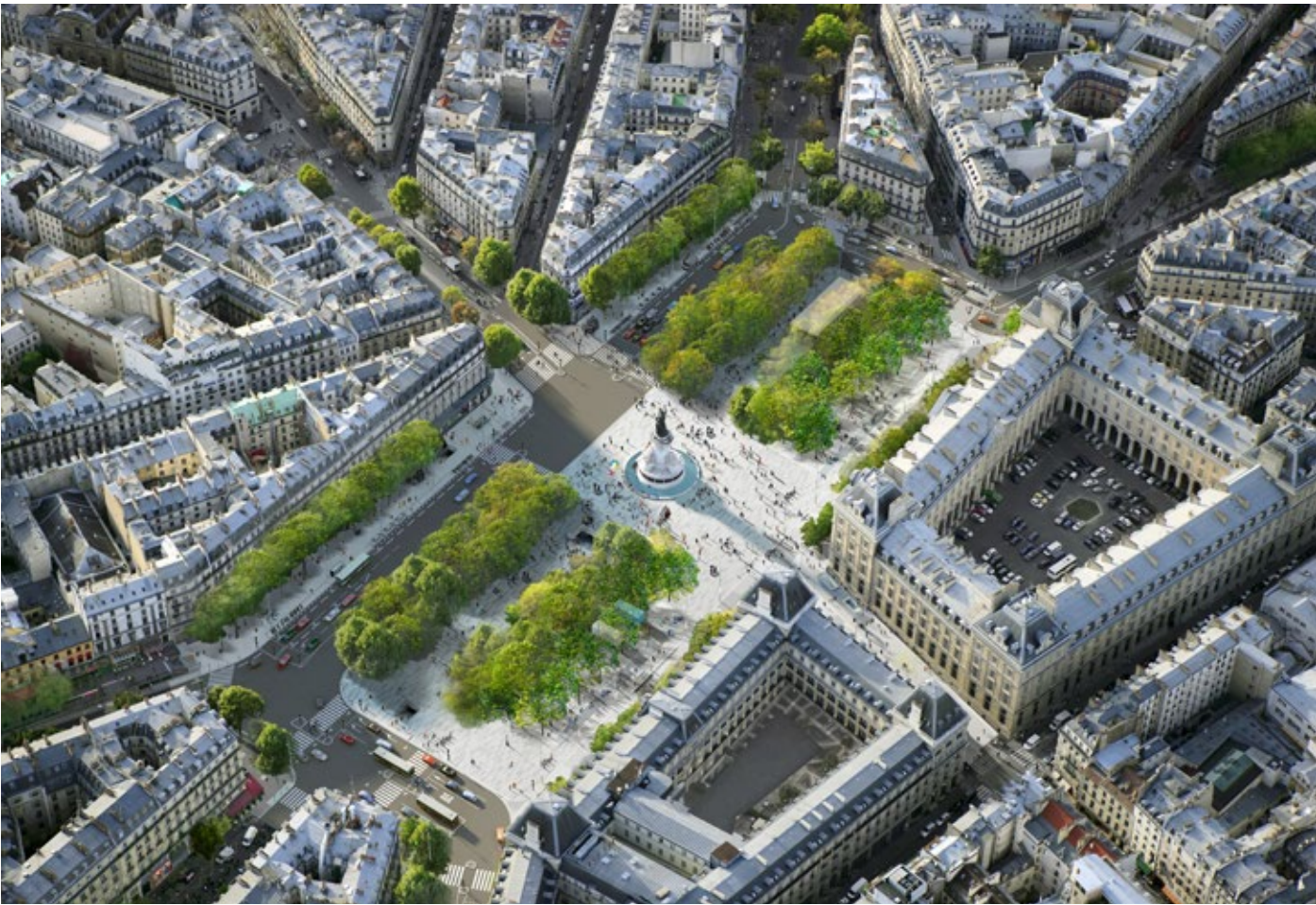
Aménagement de la place
