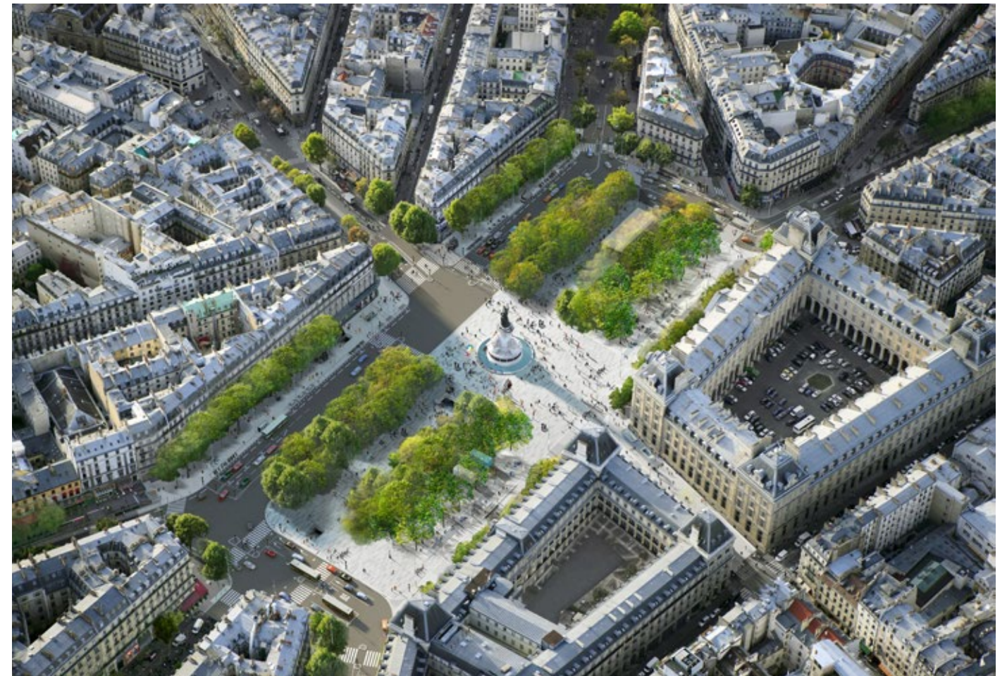
La nouvelle Place de la République
