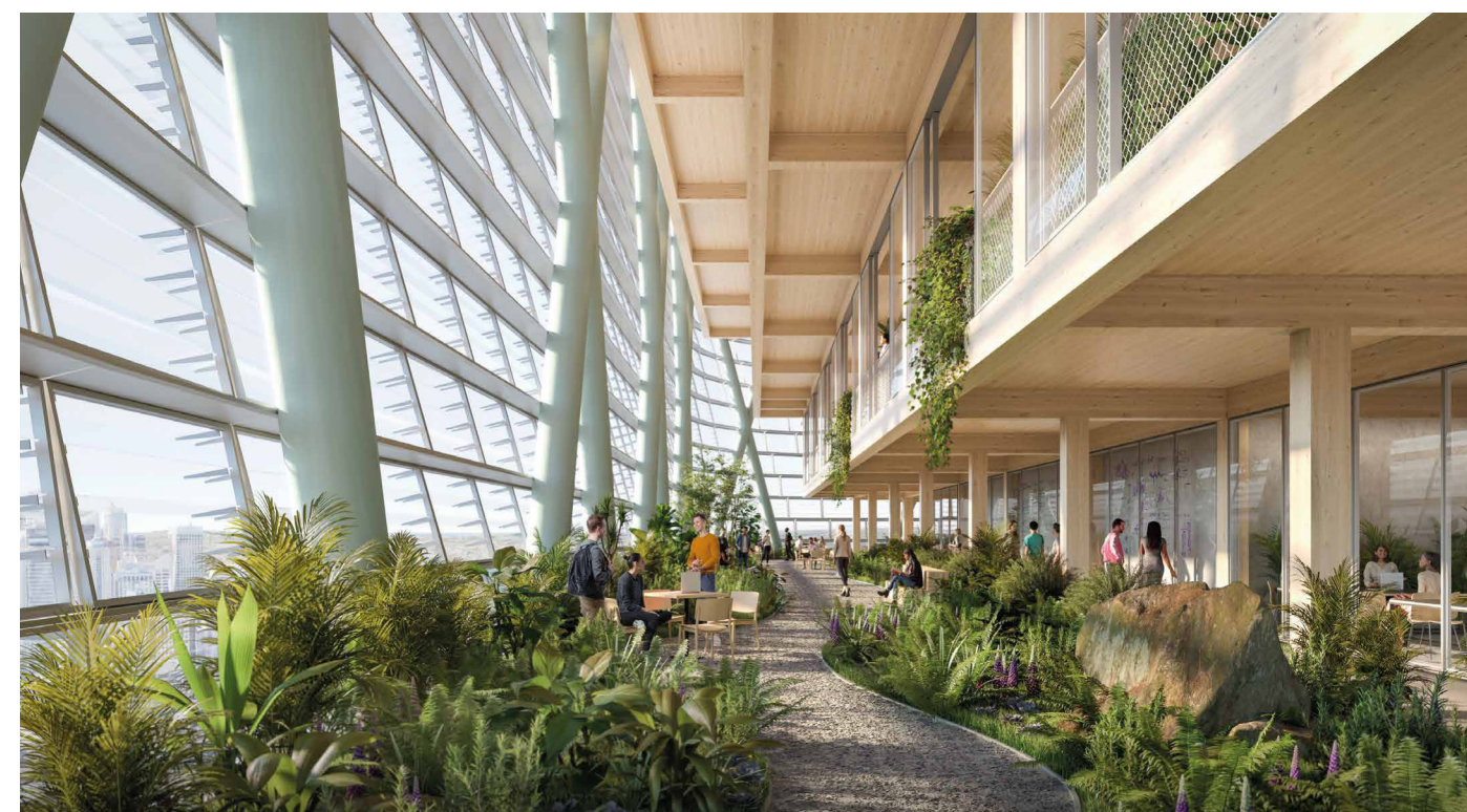
Hybrid-Hochhaus in Sydney: Eine Stahl-Glasfassade hüllt aufeinander gestapelte Holzhäuser ein. Nur jedes vierte Geschoss ist eine konventionelle Konstruktion. Die Zwischenräume sind parkartig gestaltet. Hybrid high-rise in Sydney: a steel-and-glass façade encloses wooden buildings stacked on top of one another. Only one in four levels was built using a conventional construction method. The intermediate spaces were designed like a park.
